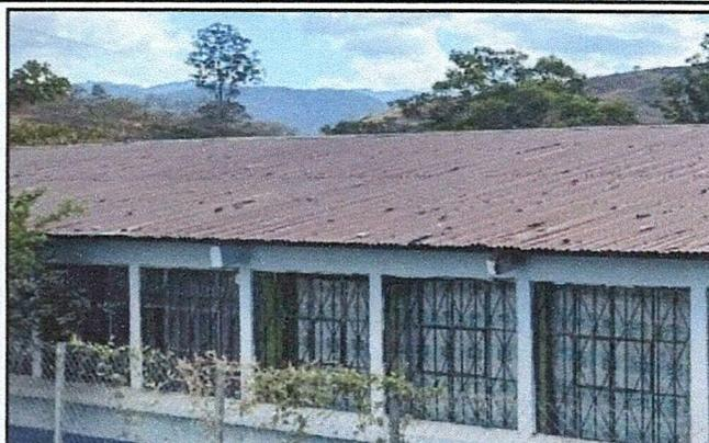
Foto 2: LAMINA DETERIORADA
